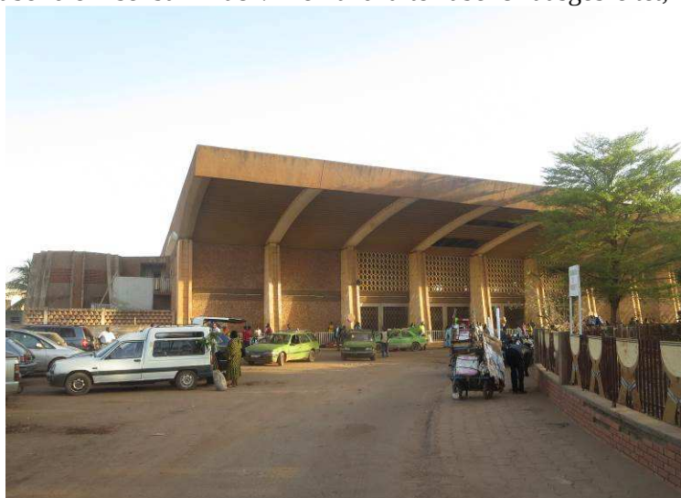
der moderne Bahnhof von Ouagadougou
