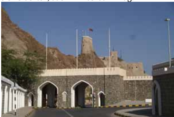
Restaurierte Stadtmauer von Muscat und eine von 3 Burgen
