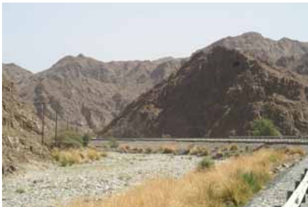
Die ausgebaute Straße durch den Hadjar al Ghabi
