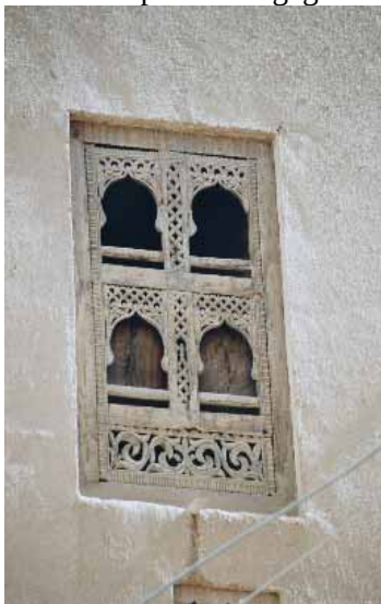
Abb.34 Fenster von außen
