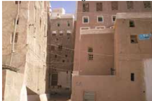
Abb. 30: Kompakte Bauweise dig 07d-ARA
