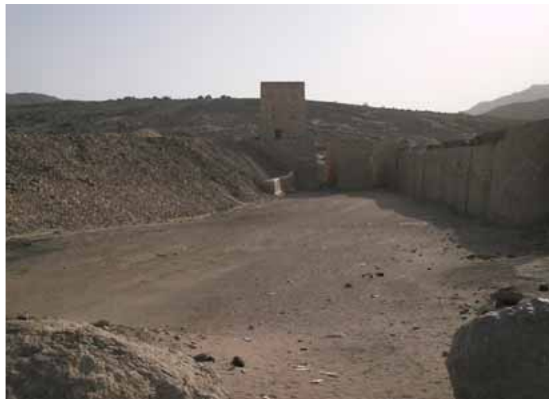
Blick vom Damm auf die 1500 Jahre alten Schleusen
