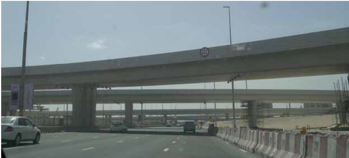
Straßenanbindungen vor der Auffahrt zur Palme von Jumairah
