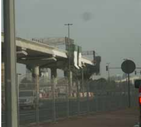
Bau des Monorails
