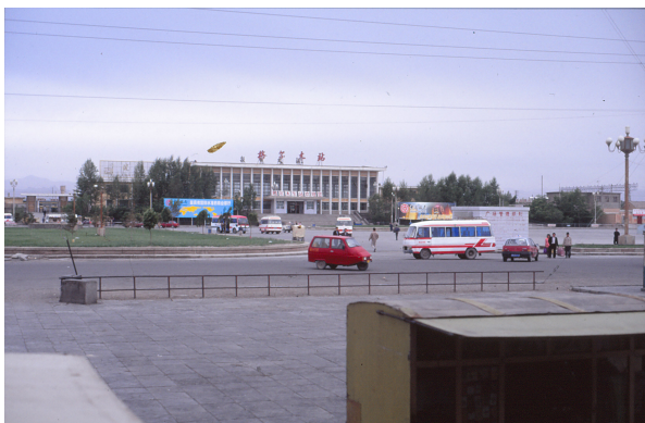
Der Busbahnhof von Golmud ist mein heutige Ziel zu fahren. Vorher mache ich noch eine Aufnahme.
