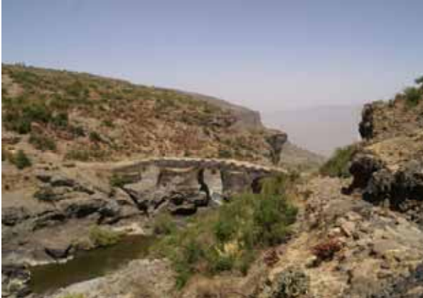
Die alte von Portugiesen gebaute Straße mit Brücke.
