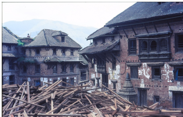
Immer wieder Baustellen Von der UNESCO werden Hilfen zur Sanierung der Stadt geleistet
